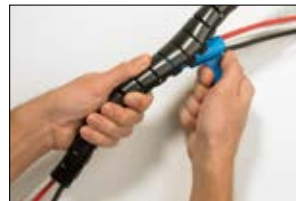
Helawrap wird nun nach dem Reißverschlussprinzip montiert.
