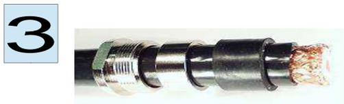
Mit einem Messer 6 mm des Außenmantels entfernen.
